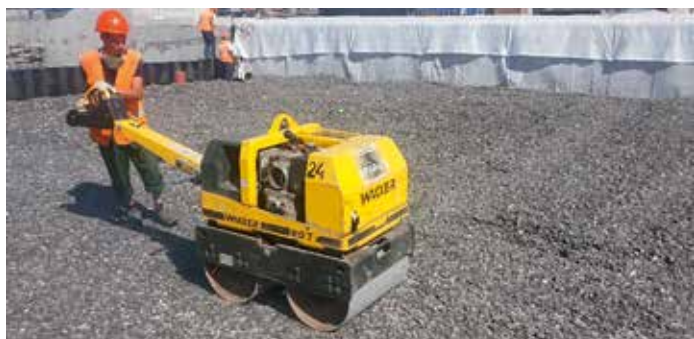
Рис. 8. Пример выполнения работ с использованием виброкатка
