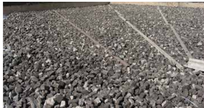
Рис. 2. Построение плоскостей при помощи металлических направляющих
